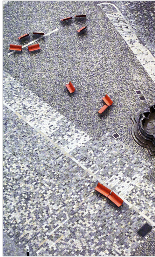
Plaza Unit Pavers
